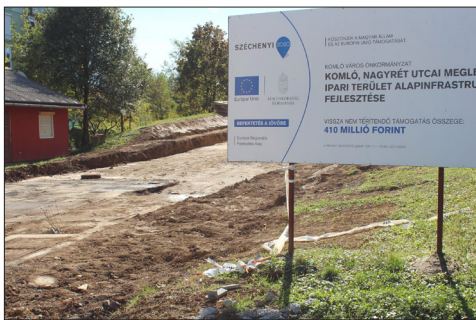
Közel 800 méteres aszfaltos út épül Nagyrét utca elnevezéssel
