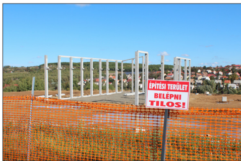
A CAADEX Kft. új üzemcsarnokot épít a Nagyrét utcai iparterületen
