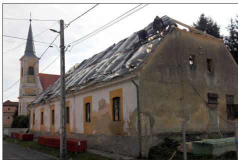
Megújul a Mecsekjánosiban található parókia tetőszerkezete
