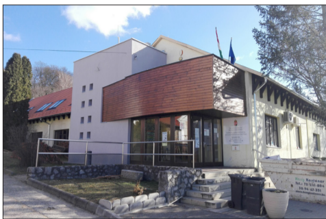
Felújítják a Komlói Munkaügyi Központ tetőszerkezetét
