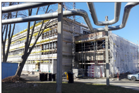
Egy állami forrásnak köszönhetően megújul a Komlói Járásbíróság épülete
